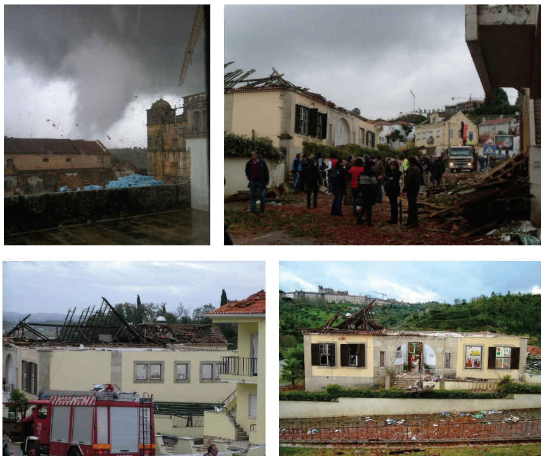
Figura 12 – Danos causados por um tornado registado no município de Tomar.
